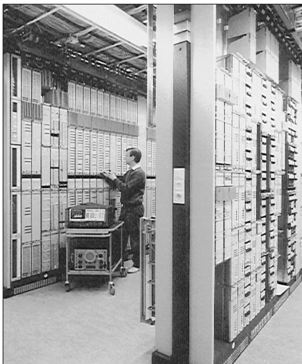
**FOTOGRAFIA.** Normalmente los equipos multiplexores PDH se desarrollaron bajo la técnica de instalación *Slim-rack*. Los bastidores tenían las dimensiones 120x2200 mm de ancho y alto. Actualmente dicha técnica se reemplazó por **ETSI N3** de 600x2000 mm. En la fotografía se muestra una sala de equipos de la década `80.
