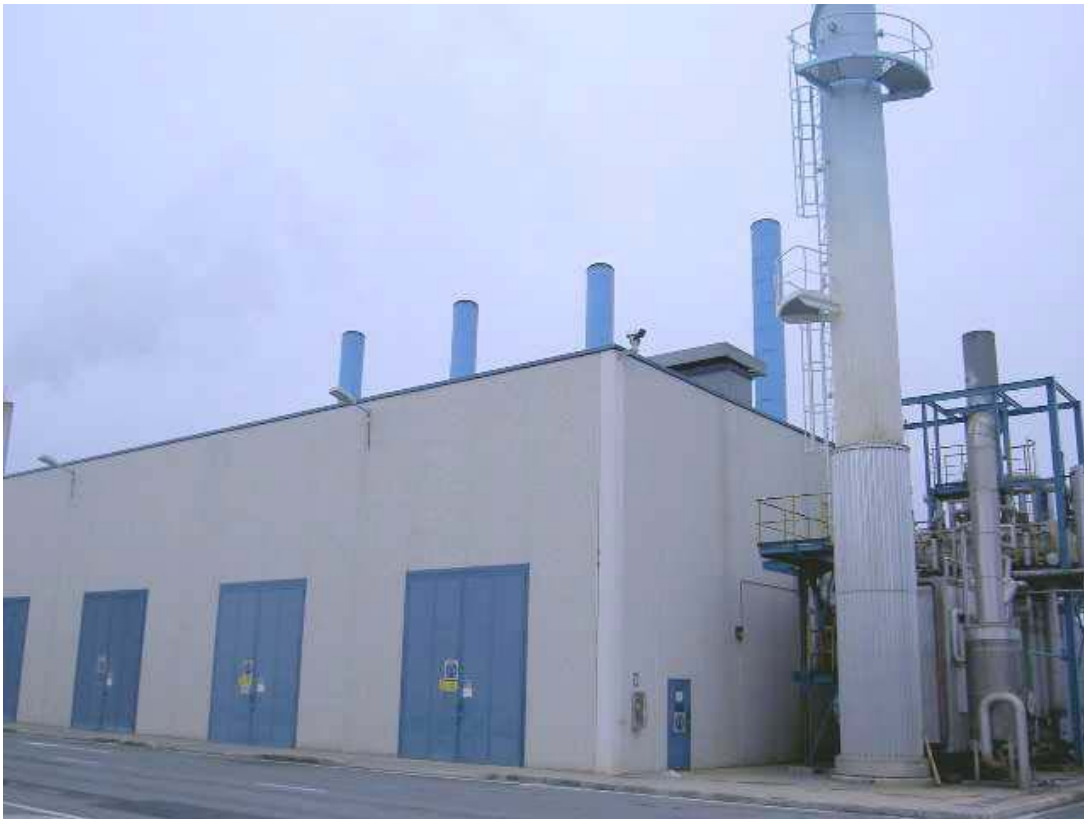
Figura 7: Vista exterior de planta de cogeneración antigua (salas de motores y caldera de recuperación)
